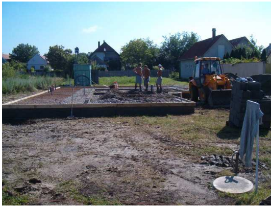
fogadószerkezet betonozása
