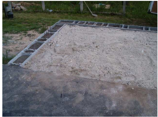
fogadószerkezet kavicsfeltöltése
