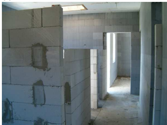
válaszfal bekötések, áthidalások
