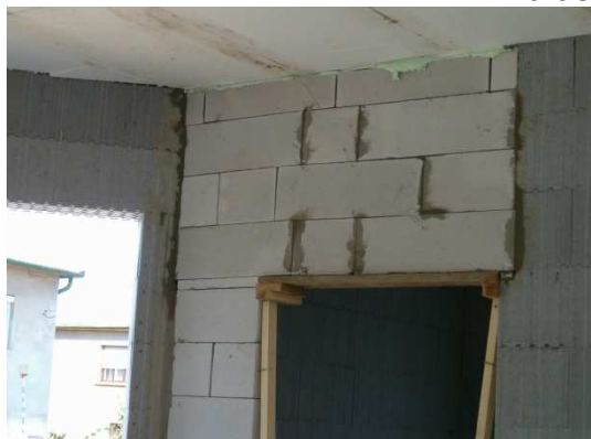
válaszfal bekötések, áthidalások
